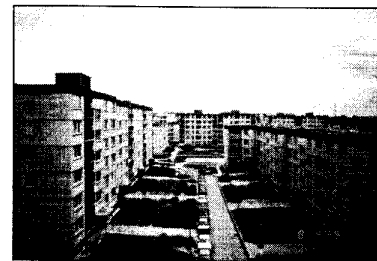
Obr. 3 Ostravské sídliště Dubina, panelové domy OP 1.11
