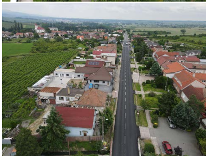
Zrekonštruovaná vozovka technológiou recyklácie za studena na mieste. Zdroj: Bratislavský samosprávny kraj
