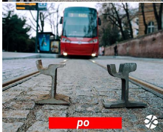
Električková trať na Americkom námestí Zdroj: Dopravný podnik Bratislava
