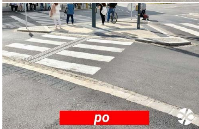
Račianske mýto pred a po rekonštrukcii. Zdroj: Dopravný podnik Bratislava
