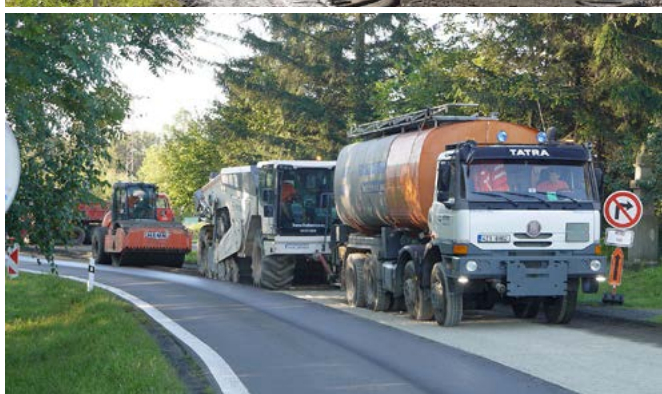
Proces recyklácie vozovky za studena na mieste Zdroj: Frekomos
