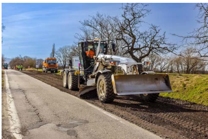
Proces recyklácie vozovky za studena na mieste Zdroj: Frekomos
