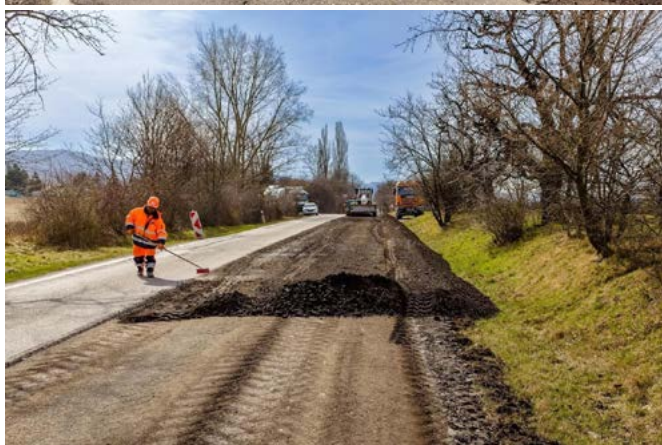
Recyklácia vozovky za studena pri Perneku. Zdroj: Eurovia
