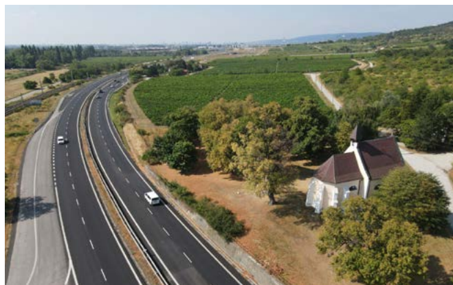
Recyklácia vozovky za horúca Zdroj: Správa ciest Bratislavského kraja
