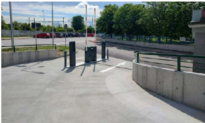
Parkovací dom v Senci pri železničnej stanici Zdroj: Mesto Senec
