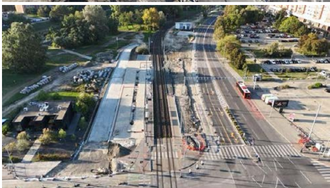
Výstavba druhej etapy električkovej trate v Petržalke (september 2024). Foto: Michal Feik
