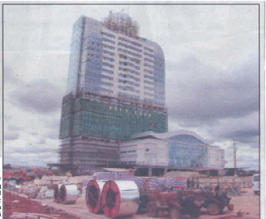
Les travaux de finition en cours au nouveau complexe hôtelier
