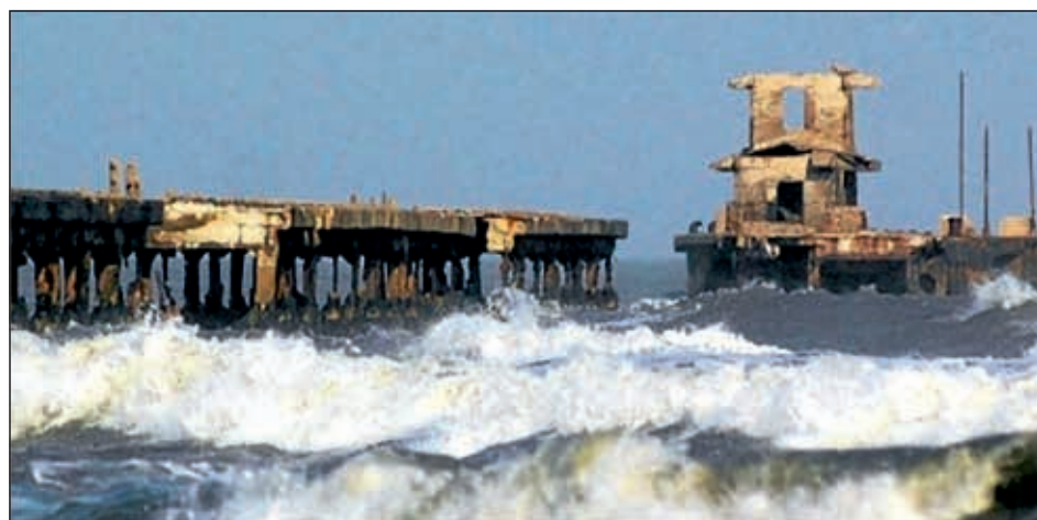
Foto 2. Muelle de Puerto Colombia
