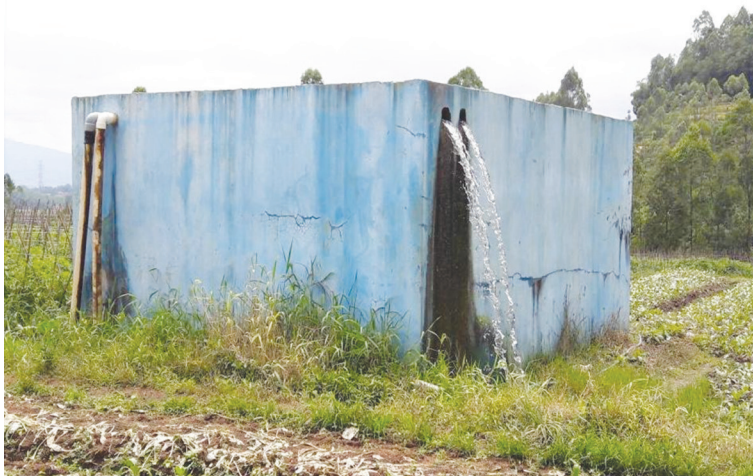
Gambar 2.4 Distribusi Air Menggunakan Bak Penampungan
