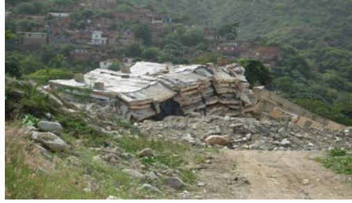
Demoliciones inconclusas, edificaciones afectadas Los Corales
