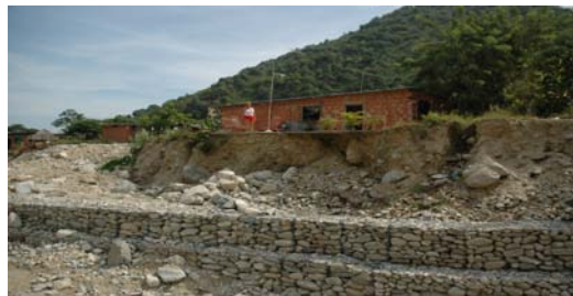
Vivienda al lado del cauce del río San Julián
