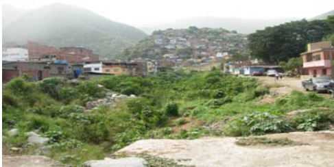
Canalización no concluida en Piedra Azul
