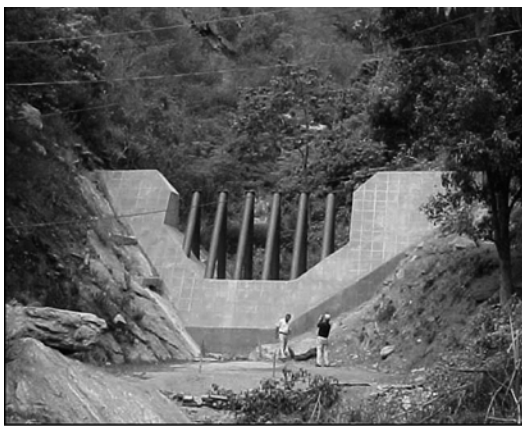
Presa de rastrillo en río Tacagua
