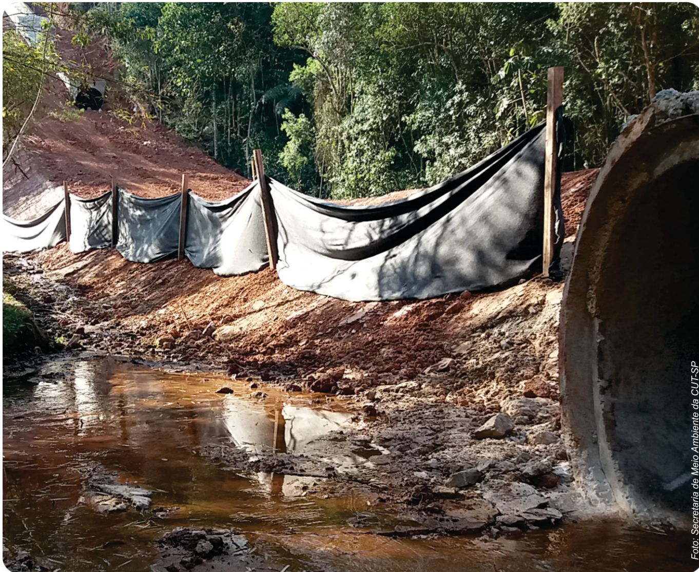
Mata ciliar desmatada e curso d'água assoreado pelas obras de transposição de águas da Represa de Jaguari para a Represa de Atibainha
