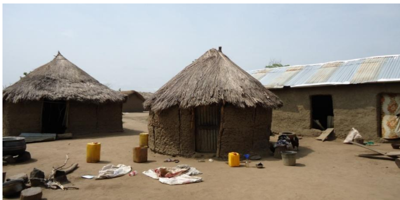
Photo 1 : Vue partielle de la ferme Okpara sur la rive gauche (Nigeria), qualité d'habitat
