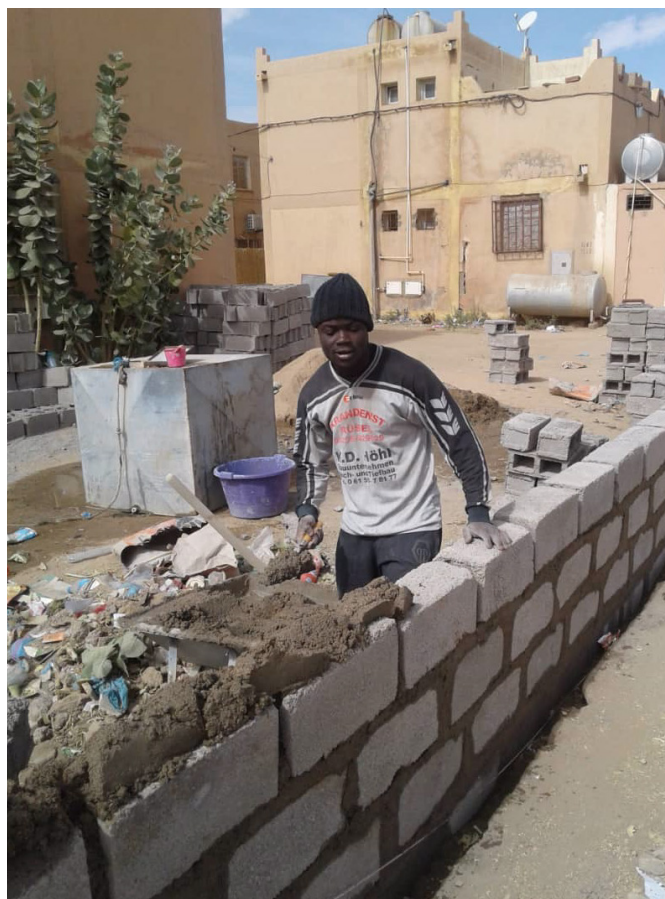
... tantôt maçon à Tamanrasset.
