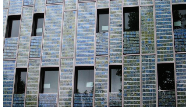
الشكل ٢٧: الألواح الكهروضوئية الملونة على واجهة إحدى المباني (www.flickr.com/photos/la-citta-vita/5964294206/).
