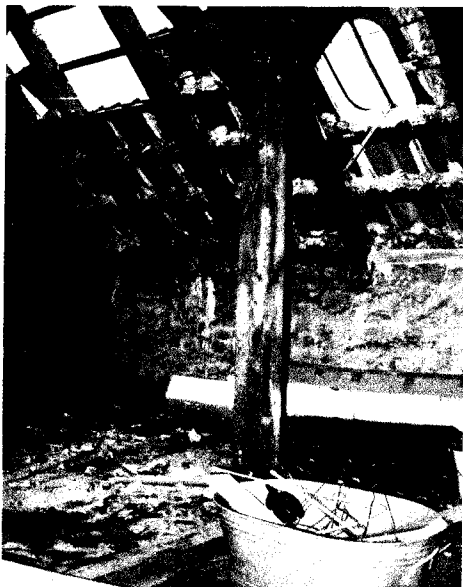
Die Absicherung von Gefahrenstellen gehört zu den Aufgaben der Polizisten im Streifendienst.
