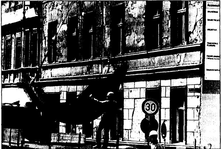
Rekonstruktion alter Bausubstanz
