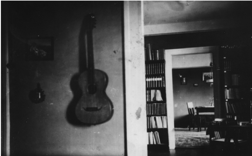
Wohnung Eugen Pragers 1913 in Erfurt (Schillerstraße)
