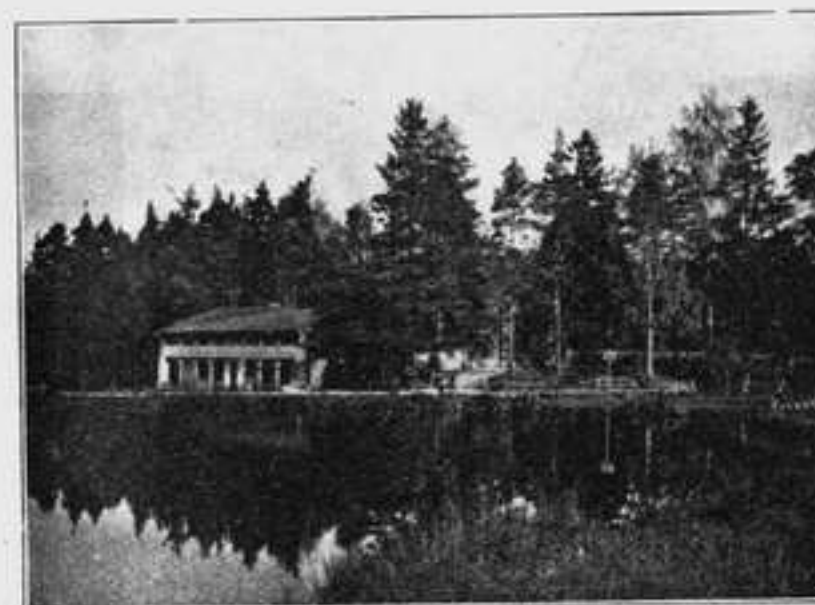
Schutzhütte bei Weidenau
