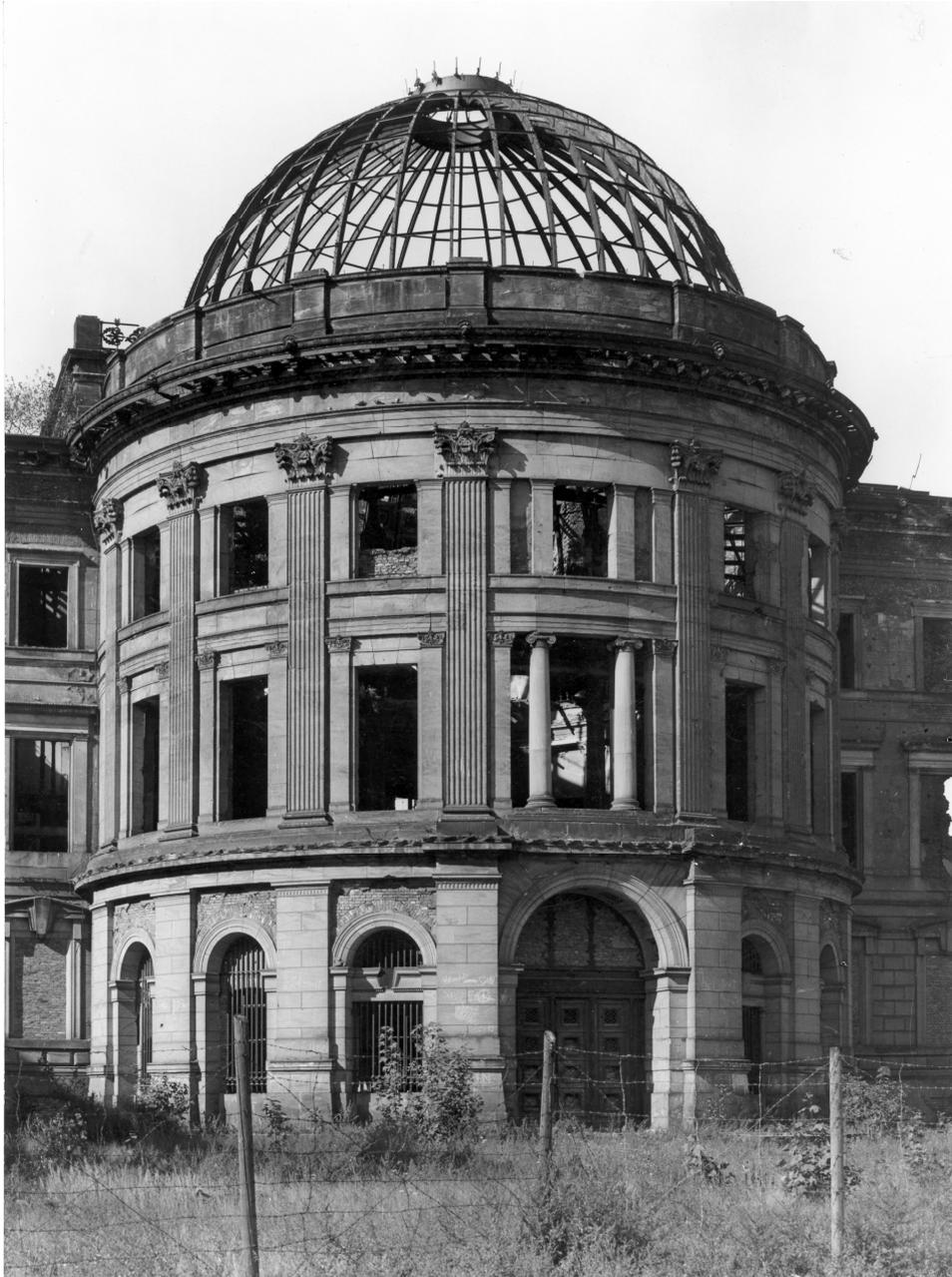
Der aufgrund seiner geschützten Lage am wenigsten beschädigte Gebäudeteil war die Rotunde mit dem noch vollständig erhalten gebliebenen eisernen Tragwerk der Kuppel.
