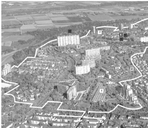
Abbildung 45 - Stadterneuerung Freiberg/Mönchfeld (LH Stuttgart, Presse- und Informationsamt 2002)
