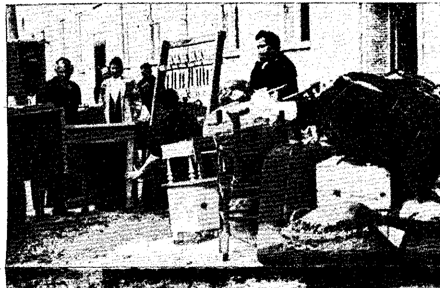
Hier ist ein Wunsch in Erfüllung gegangen. Im Rahmen der Umsiedlung bezieht diese Familie eine Wohnung in einer neuen Heimat. Viele andere Menschen werden auf die Erfüllung dieses Wunsches verzichten müssen, weil die Bundesregierung die fortlaufende Umsiedlung für überflüssig hält.
