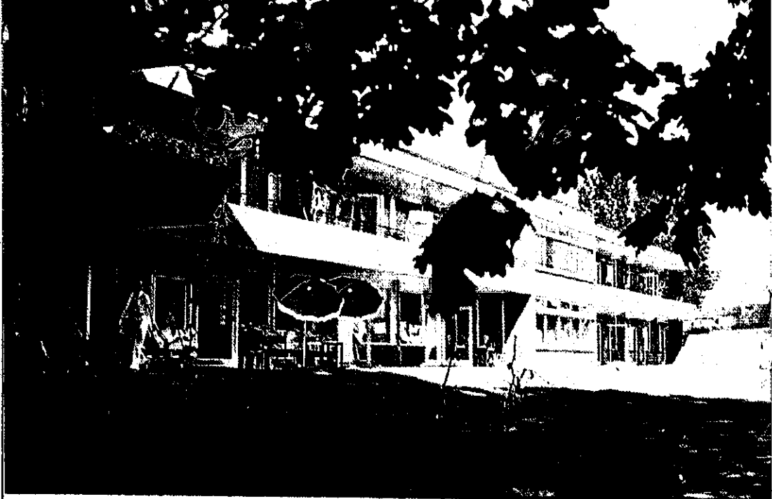
Das vorbildliche Altenwohn- und Pflegeheim der AW in Bremen-Gröppelungen.
