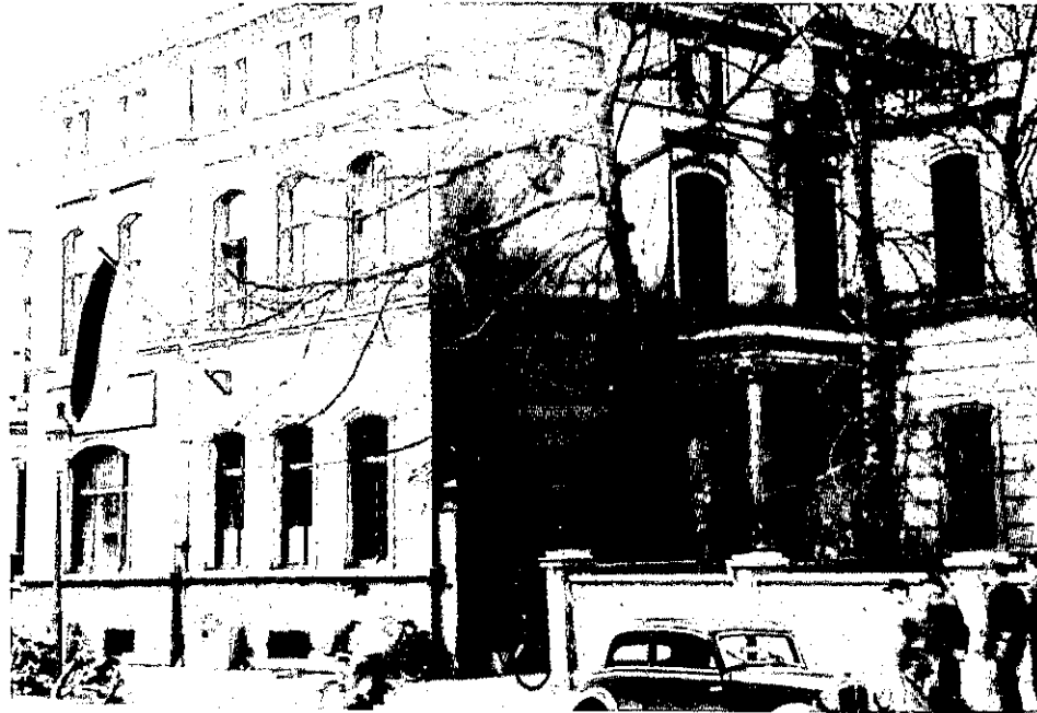
Gewerkschaftshaus Düsseldorf, Straße 98. Bis zum 28. April 1953 hatten IG Metall, ÖTV, HBV, IG Bau, NCG, IG Chemie hier ihre Duisburger Geschäftsstellen.
