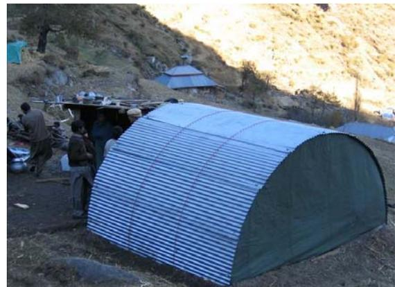
Die tunnelförmigen Notbehausungen bestehen aus über halbbogenförmige Träger gespanntem, gewelltem Eisenblech und sind inwändig mit Tarpaulin wärmeisoliert. Sie sind erdbebensicher und können dem Druck von mehreren Metern Schnee standhalten. Zum Abdecken der Eingangsöffnungen wird ebenfalls Tarpauliplane bereitgestellt. Hier bietet die Konstruktion allerdings viel Raum für lokale Anpassungen.
