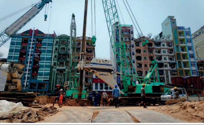
➤ Myanmar'da bir İnşaat Alanı
