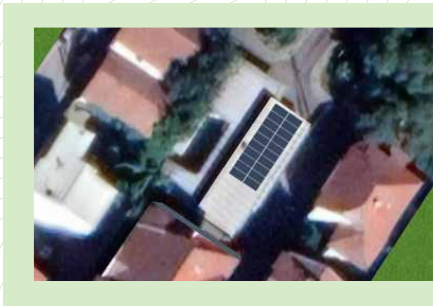
Слика 19. Визуелен приказ на предвидениот фотоволтаичен систем на кровните површини на ДГ „13ти Ноември“ – Објект Кукушка
