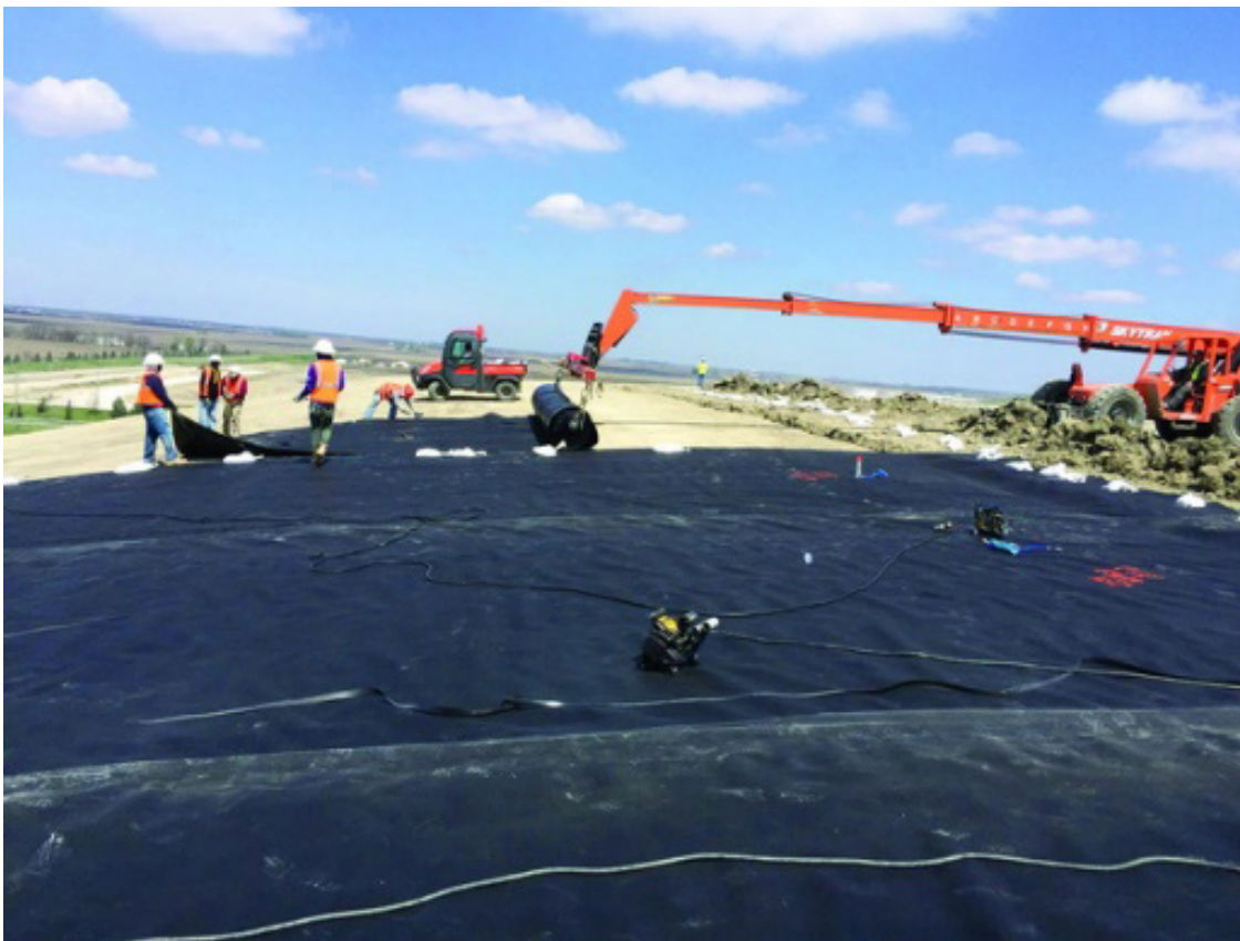
Слика 2 - Поставување на геомембрана за заптивање на депонијата
