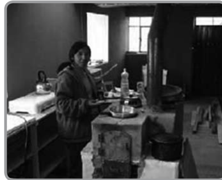
Esta casa usa una “cocina mejorada” para, como efecto complementario a la cocción de alimentos, contribuir al calentamiento interior
