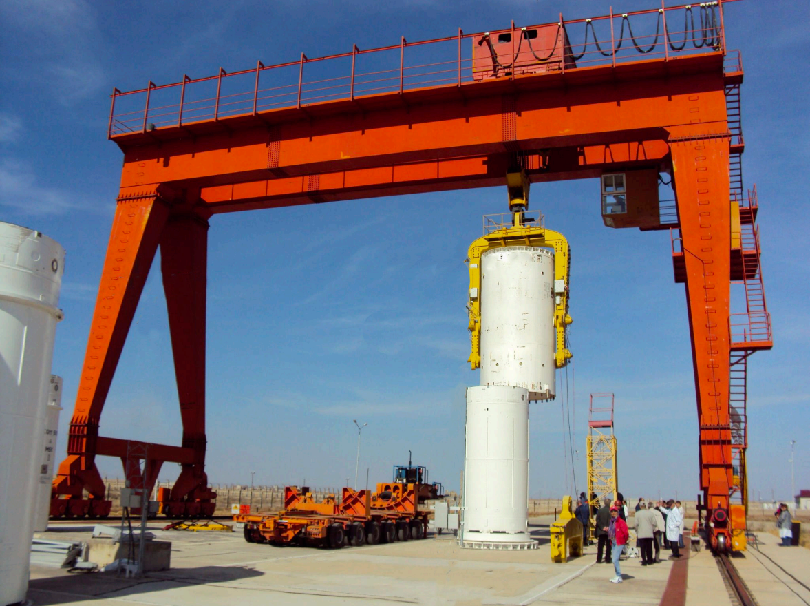
16-сурет. Байкал-1 контейнер сақтау орнында гидравликалық иінағашы бар 150 тонналық қранның контейнерден тасымалдау орамасын шешіп жатқан сәті. Эрик Хауден түсірген АҚШ командасының фотосы.
