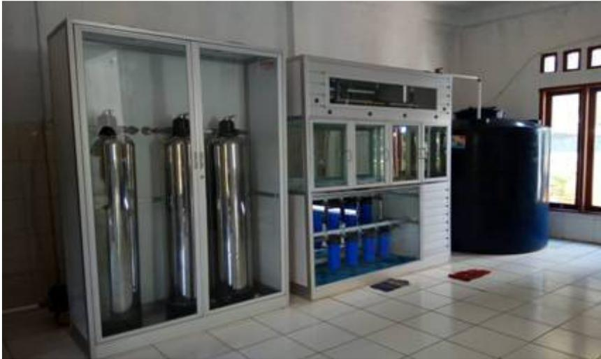
**Gambar 5.5.** Instalasi Pengolahan Air Minum dari Sumber Air di Desa Boru Kedang
