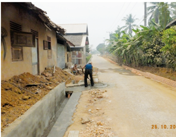
Gambar 6.7 Pembuatan Selokan/ Siring Permanen
