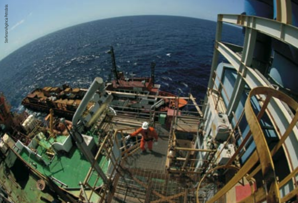
Operador trabalha na P-34
