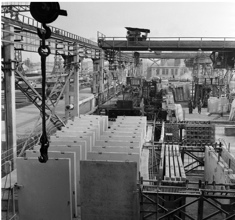
На рабочей площадке Фрунзенского ДСК. 1969. ЦГА КФД КР
