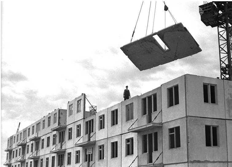
Строительство первого крупнопанельного дома. 1962. ЦГА КФФД КР
