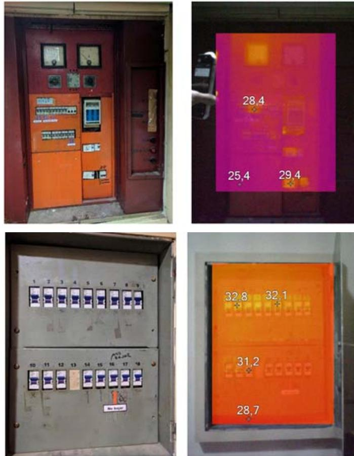
Las temperaturas visualizadas en los tableros eléctricos en condición de carga eléctrica moderada se encuentran dentro de los parámetros normales para este tipo de instalaciones y equipamientos. No se han detectado anomalías térmicas ni focos calientes.
