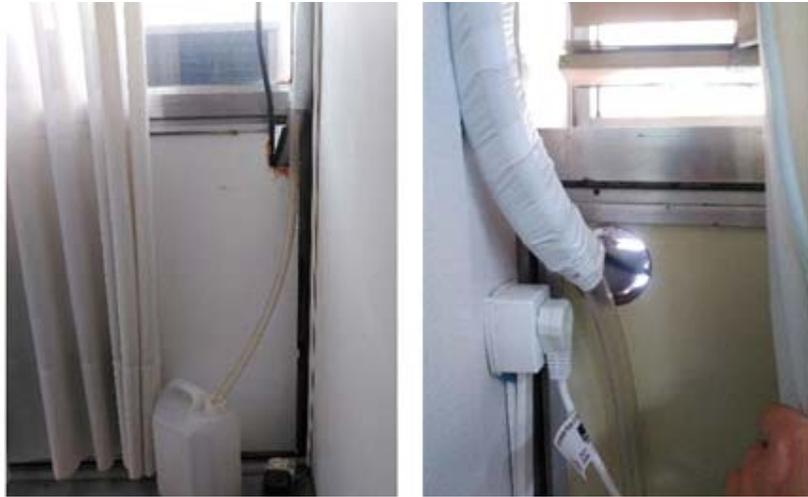
Se han observado además orificios abiertos en las conexiones de equipos de aire acondicionado y un importante flujo de aire por los mismos. También se destaca la escasa aislación térmica de los paneles de madera que se encuentran debajo de los ventanales.
