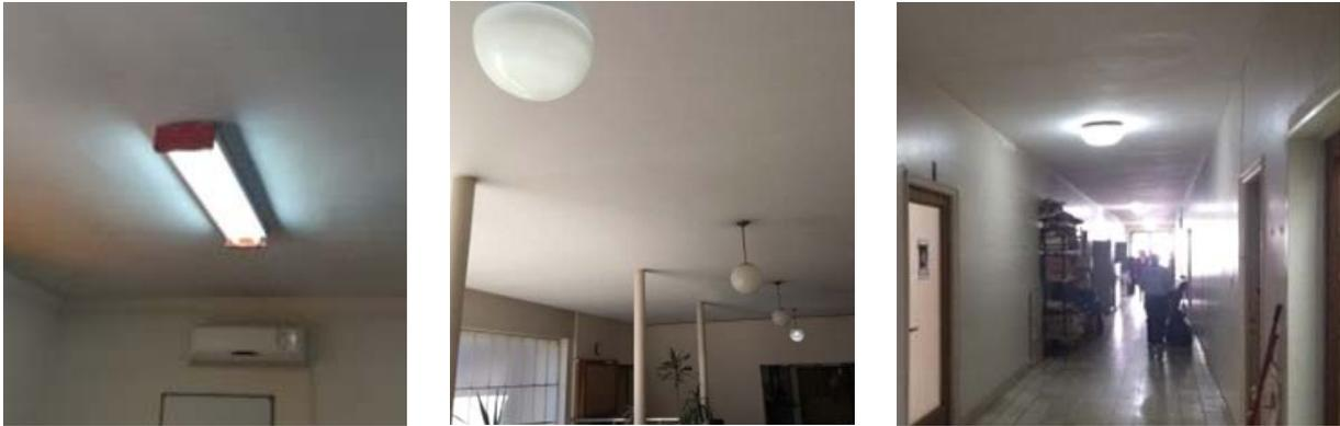
Figura 35, 36 y 37: Cielorraso de placas desmontables de yeso.
