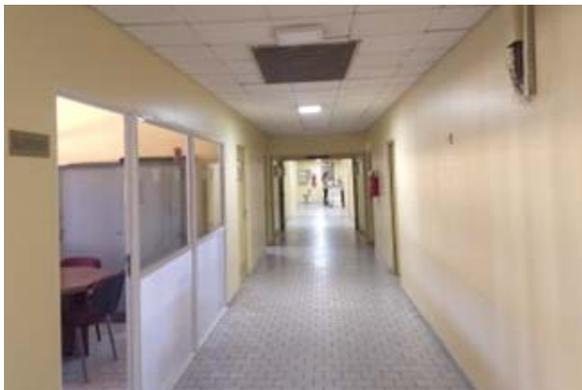
**Figura 45:** Piso original de granito reconstituido.
