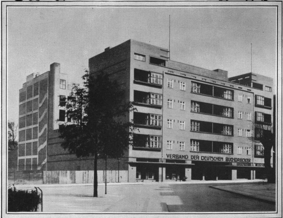
Buchdruckerei und Verwaltungsgebäude des V. d. D. B. und des Bildungsverbandes der Deutschen Buchdrucker in Berlin
