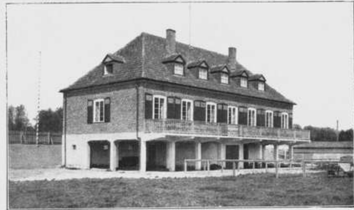
Vereinshaus der Arbeiter-Wassersport-Vereinigung Cassel
