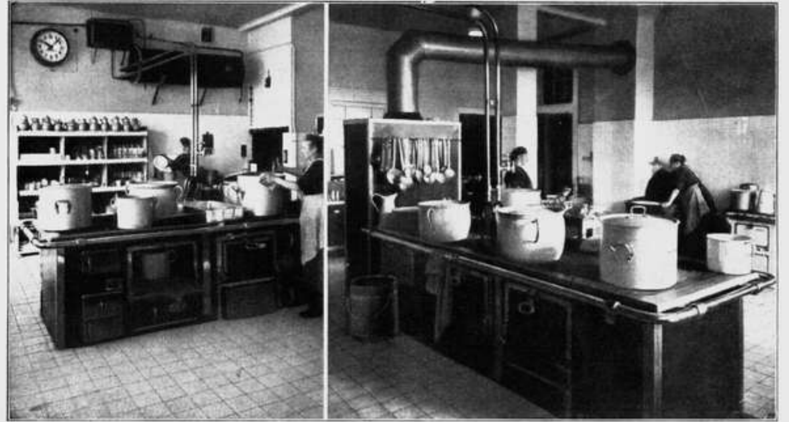
Die Küche. Rechts neben der Uhr die Wasserwärmanlage, dann der Fahrstuhl.
