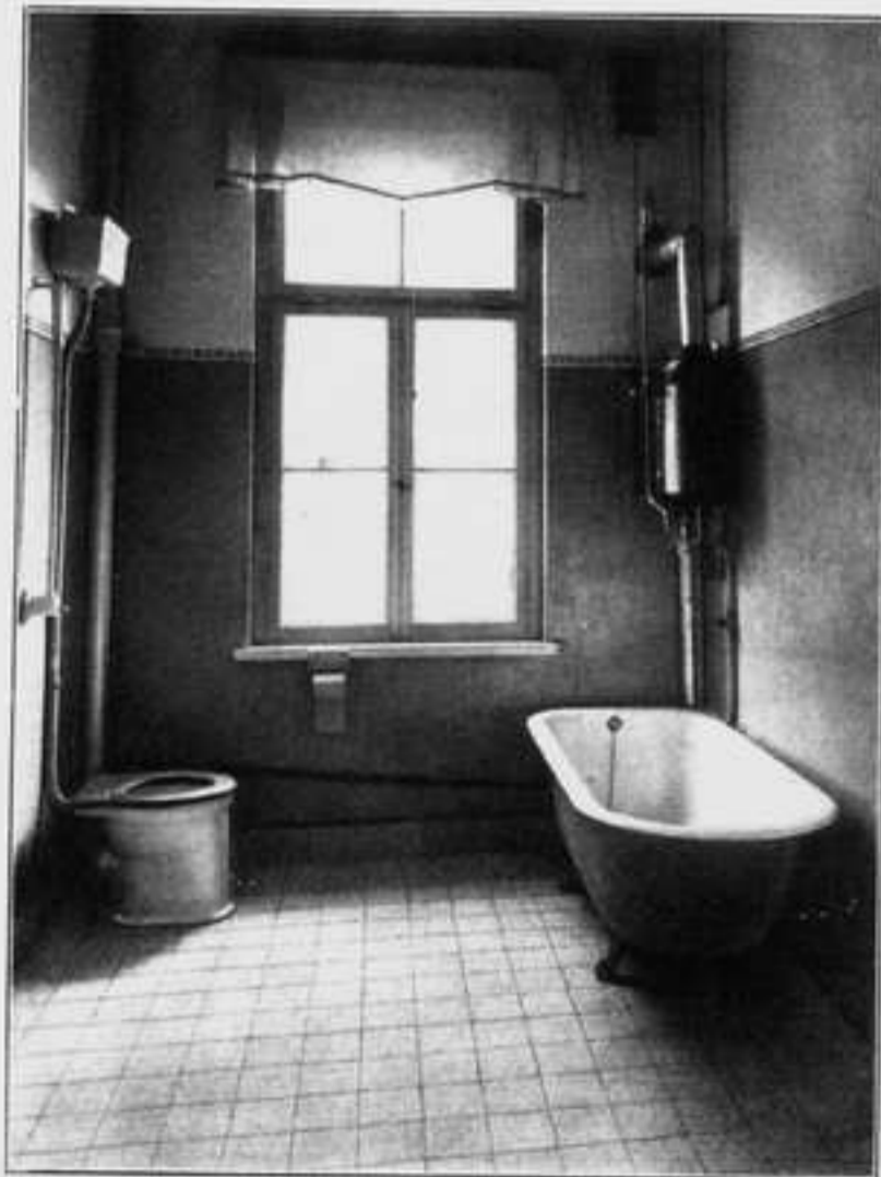
In jedem Stockwerk ist ein Wannenbad vorhanden, Abortanlagen noch besonders.
