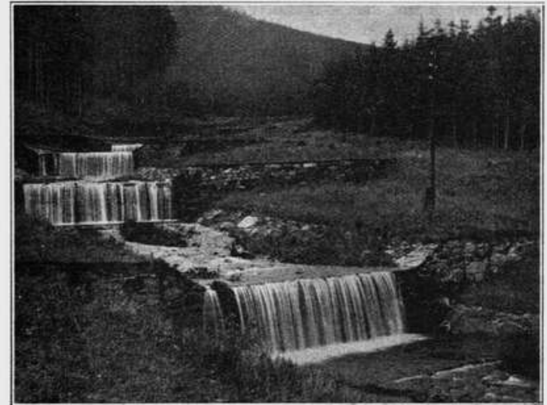
Einflang zwischen Technik und Landschaft: Bildbachverbauung Forstrat Ing. Otto Göttinger, Osto. d. Vereines.
