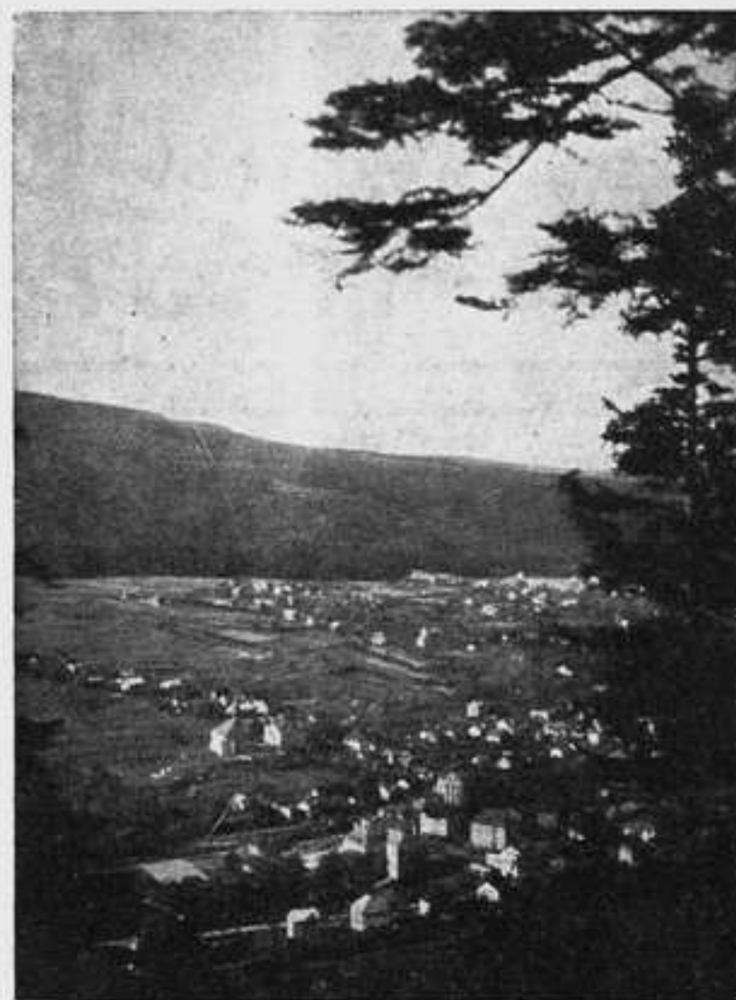
Teilansicht von Eulau.
