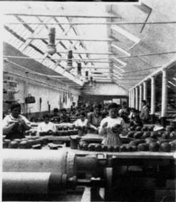
Einer der Waschsäle, in denen der Gummi gesäubert und zu Fellen gewalzt wird.
