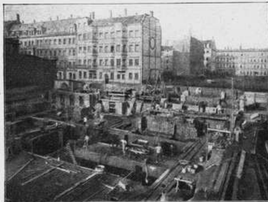
Bild 1. Ein Blick auf den Neubau der Arbeiter-Turn- und -Sportschule in Leipzig. (Stand des Baues am 20. Januar 1925.)
