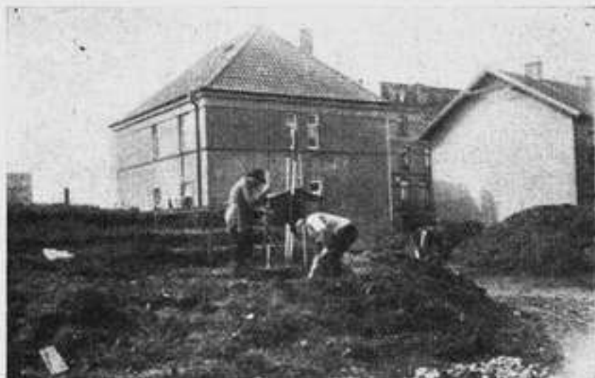
Nivellierung der Tribünen, im Hintergrund das Verwaltungshaus
