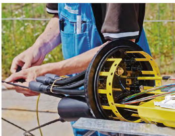
Installation eines Glasfaserkabels
