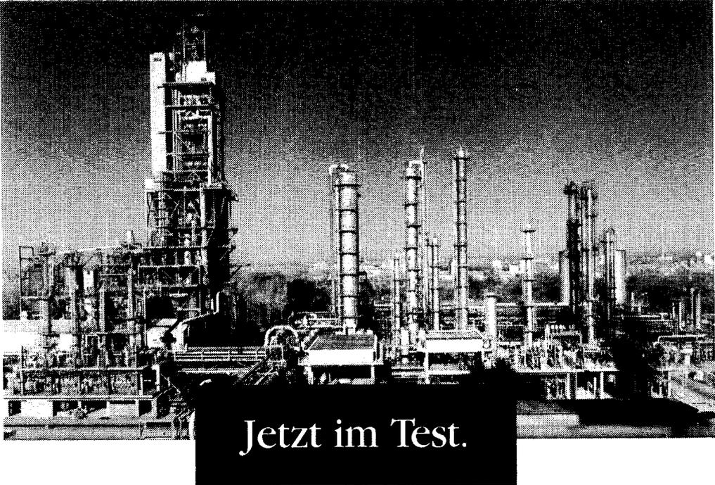
Ein großer Schritt nach vorn auf dem Weg zum Braunkohlenkraftwerk der Zukunft: In Wesseling hat eine Anlage ihren Betrieb aufgenommen, die Braunkohle in Brenngas umwandelt. Sie ist das Kernstück eines neuen Kraftwerktyps, in dem aus der gleichen Menge Kohle 25% mehr Strom erzeugt werden kann. Entsprechend geringer ist der CO<sub>2</sub>-Anfall.
