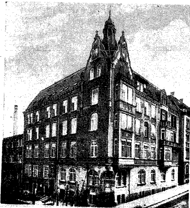
Das Verbandshaus in Stuttgart, dessen Räume den technischen Verbandsbetrieb nicht mehr zu fassen vermochten.
