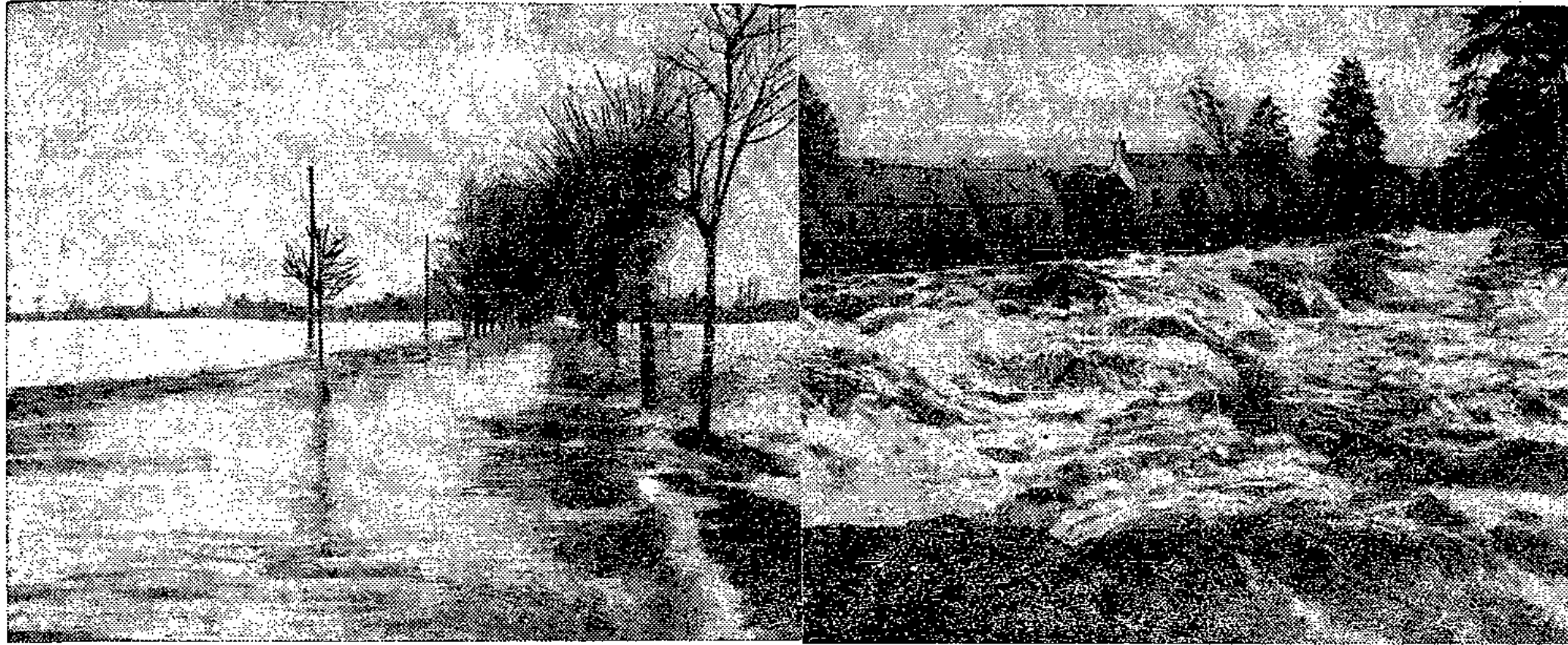
Südfrankreich Der Dohart-Fluß stieg über die Ufer.
