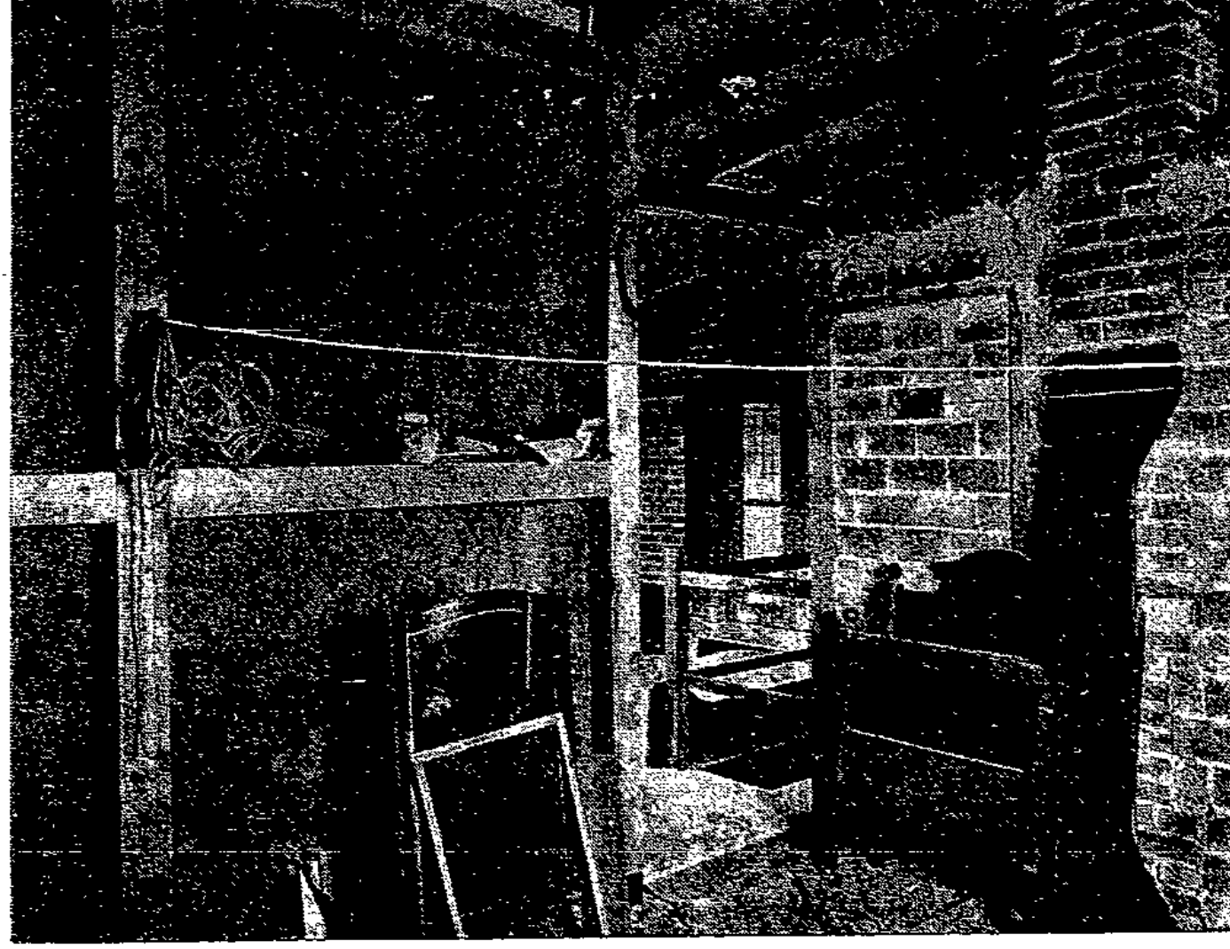
Blick in das noch nicht ausgebaute Obergeschöß.
