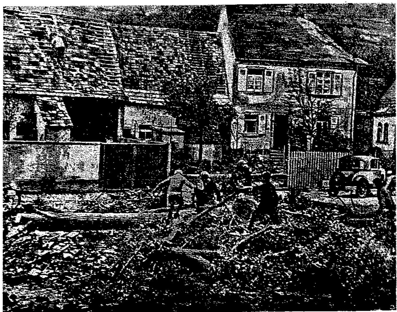
Der Ort Lautenbach bei Weinheim an der Bergstraße wurde, wie hier bereits am Sonnabend berichtet, von einem schweren Anwetter heimgesucht. 150 Häuser wurden abgedeckt. Es entstand ein sehr erheblicher Sachschaden.
