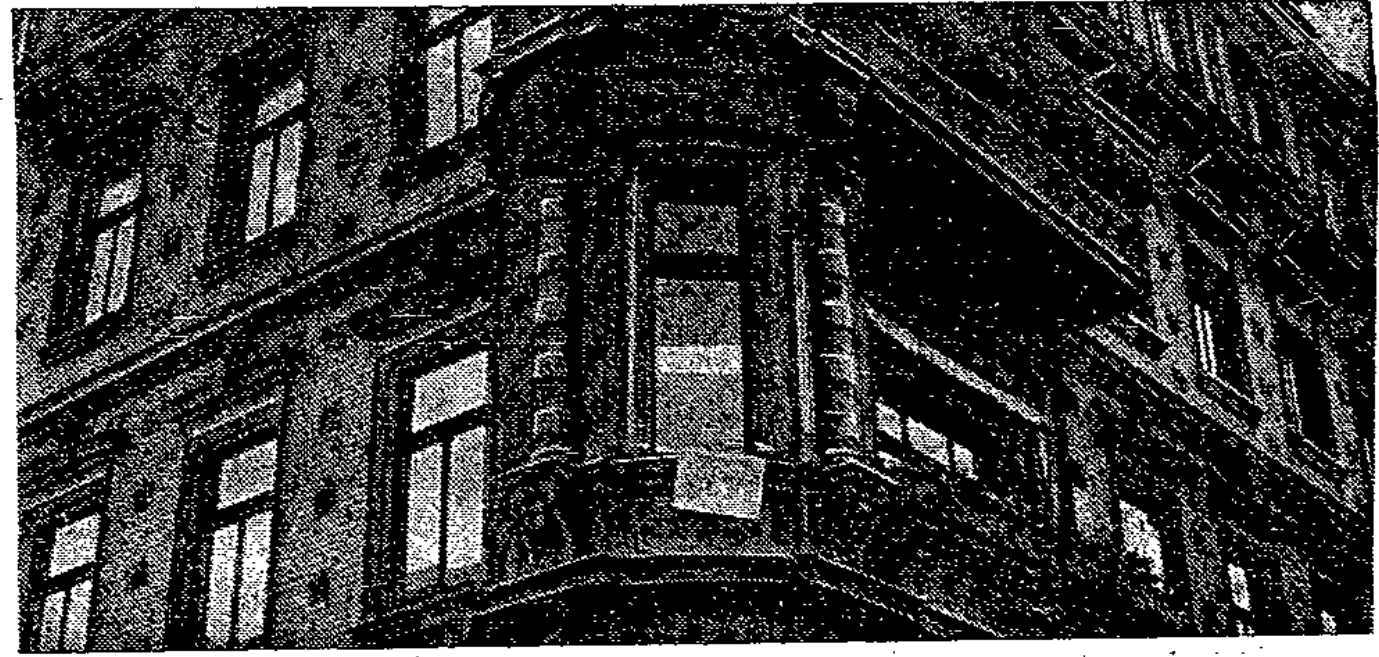
Die „Belle-Etagen“ in den Prozenvierteln stehen zum großen Teil leer. Ein Haus in der Augustastrasse.
