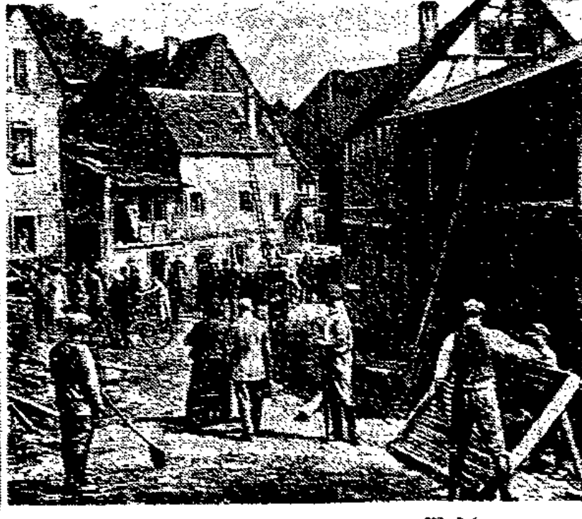
Nach dem Unwetter an der Mosel.
