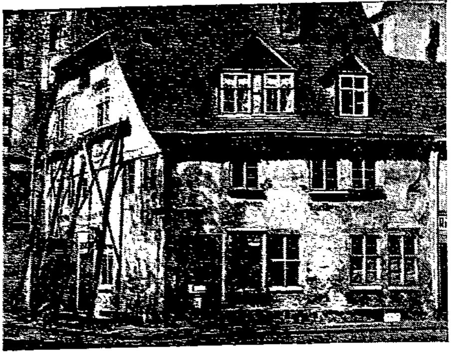
Das alte Haus an der Braunnhirschstraße. Nur die Dachwohnung ist noch bewohnt.
