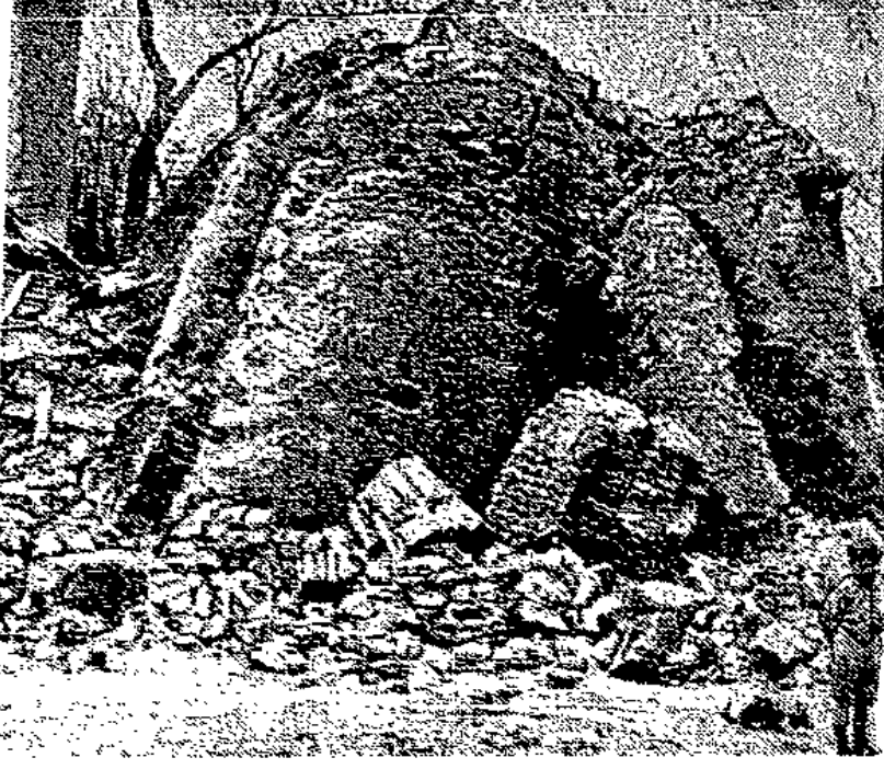
Historisches Baudenkmal eingestürzt.
