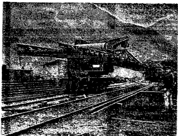
Abb. 2: Der Spezialkran, der die Gleisrahmen von und zur Baustelle befördert. Der Kran hat einen 30 Meter langen Gleisrahmen hochgehoben
