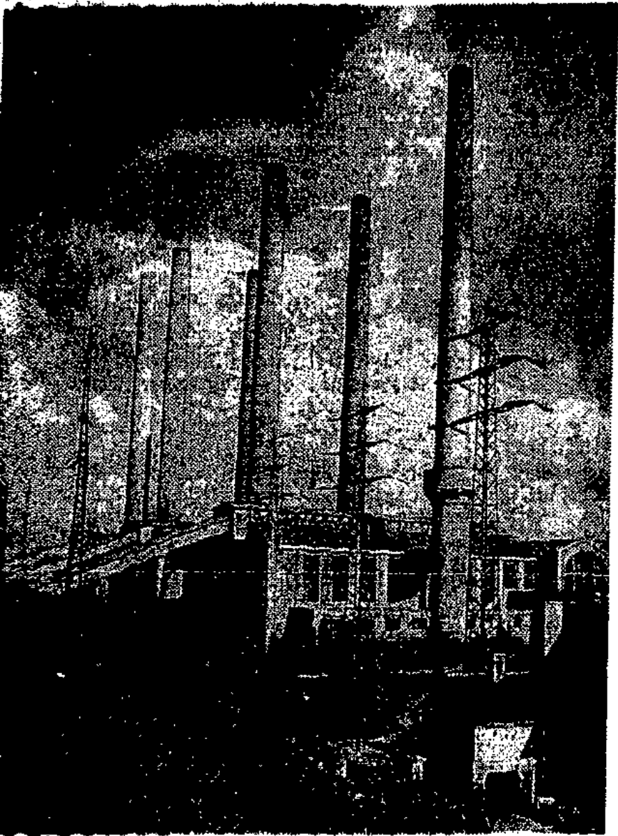
Gesamtansicht des Braunkohlen-Großkraftwerks Finkenheerd mit seinen sechs über 100 Meter hohen Schornsteinen. Links sind die Förderanlagen zu erkennen, mit denen die drei Kesselhäusern die Kohle aus den Reservebunkern zugeführt wird.
