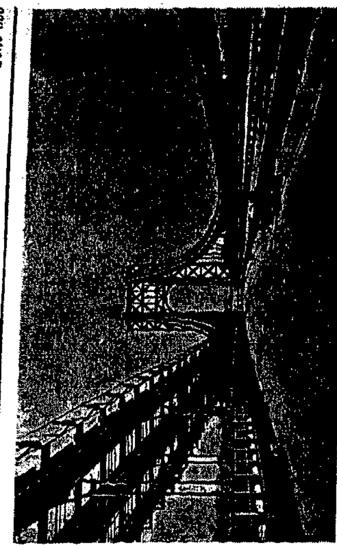
Der Welt längste Fingerring. In Newport ist die neue George-Washington-Brücke über den Hudsonfluß, die Manhattan und New Jersey miteinander verbindet, eröffnet worden. Sie ist die längste Fingerring- der Welt. Die Länge des Hauptbogens beträgt 1125 Meter. Der Fahrbahn liegt 80 Meter über dem Fluß. Die Krone der Pfeiler steigt mehr als 200 Meter über das Wasser empor. Die Brücke ist in 4 1/2 Jahren mit einem Kostenaufwand von 60 Millionen Dollar erbaut worden.
